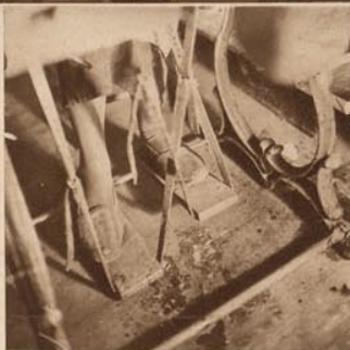
ENVELOPPES ET PAPIER A LETTRES. — Il y a de grandes machines toutes neuves qui prennent le papier, le plient, le gomment, le doublent. D'autres, semblables à d'anciennes machines à coudre, fonctionnent grâce à un mouvement de pédales. (Photographies prises aux usines Blancan.)
